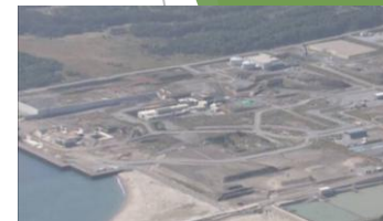
東通原子力発電所（東京電力）
