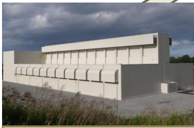
使用済み燃料中間貯蔵施設
